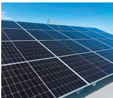
屋上に太陽光パネルを設置
