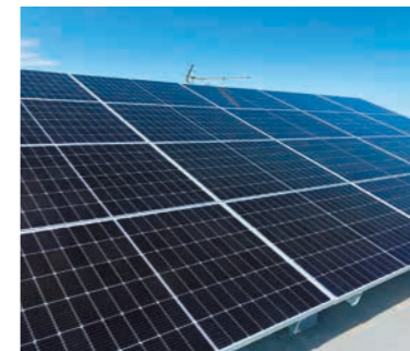
屋上に太陽光パネルを設置
